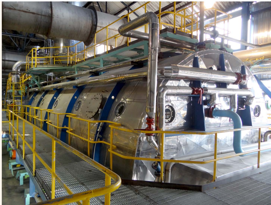
Tacho continuo de 300 m3 fabricado por COIN con licencia de Fives Cail - Fives Fletcher
