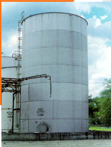
Tanque almacenamiento 580 m3 normas API, acero inoxidable, fabricado por COIN
