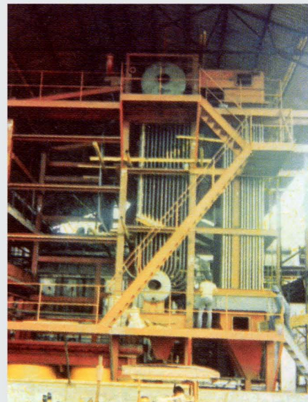
Equipos complementarios para caldera de 120.000 lbs/hr de evaporación, fabricados por COIN
