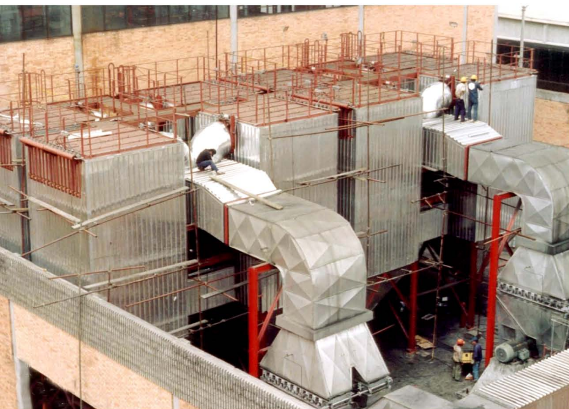
Sistema de ocho filtros de mangas totalmente automatizado para dos calderas, fabricado y montado por COIN para la Industria Cervecería de Colombia.
