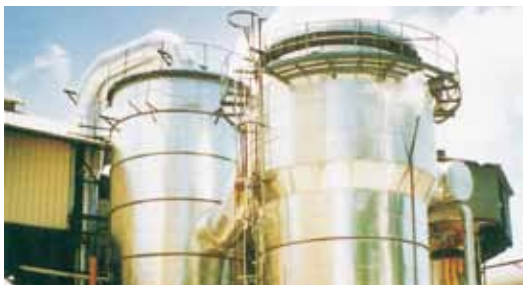
Evaporador de película ascendente Fives Fletcher tipo Kestner, 4000 m 2 - GUADALUPE
