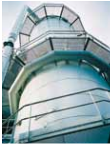
Evaporador de película descendente, diseño remolacha - 7540 m 2
